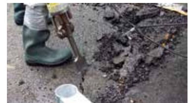
Burinage au marteau piqueur pneumatique.
