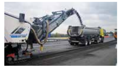
Fraisage d'enrobés sur autoroute.
