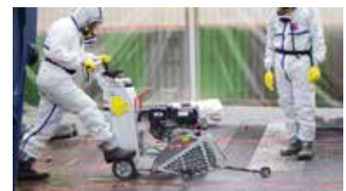
Opération de sciage avec arrosage automatique.
